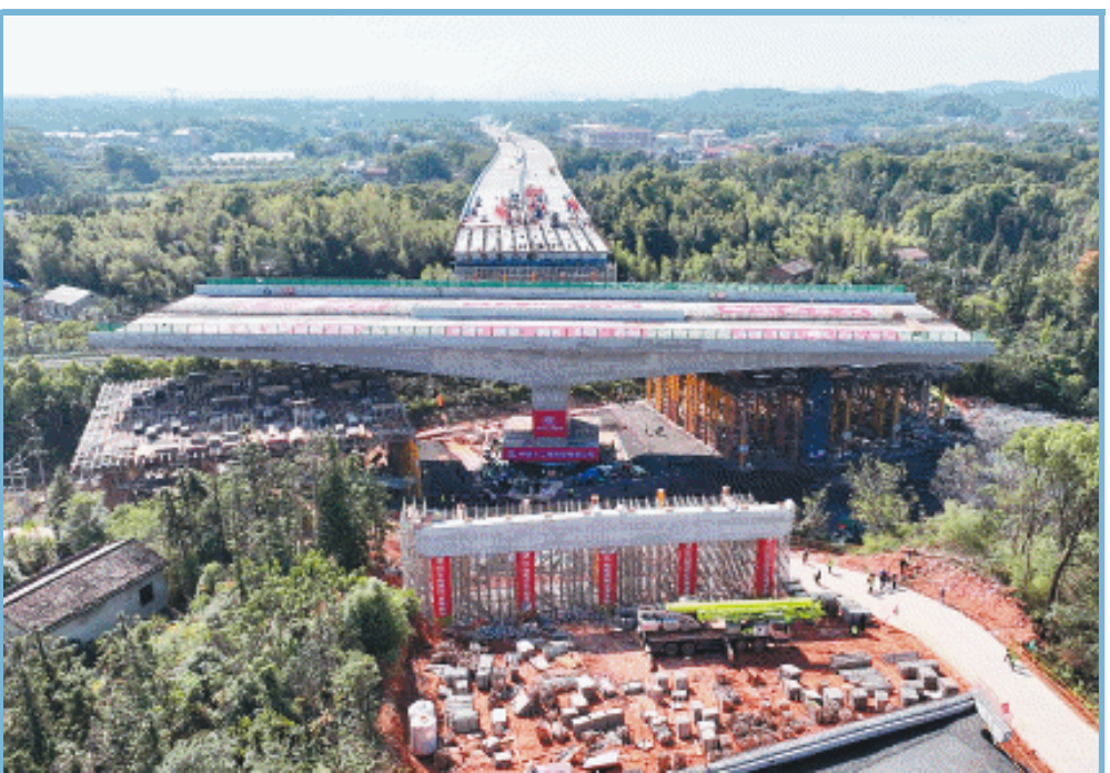
27日中午,醴娄高速上跨沪昆铁路桥以球铰支座为圆心,以每分钟1.73°的速度顺时针缓慢旋转,完成转体合龙。长沙晚报通讯员 刘雄峰 摄
