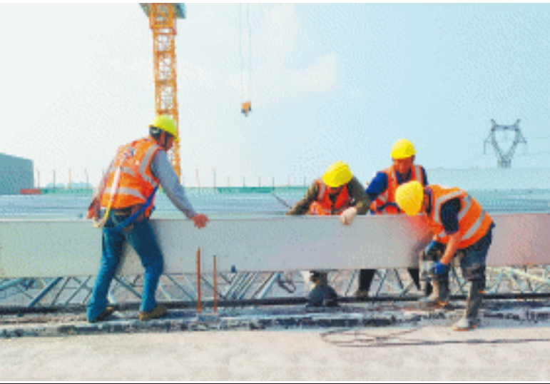
雅礼中学东校区(二期)项目建设现场,建设者正在进行屋面网架钢结构施工。长沙晚报通讯员 罗霜 供图
