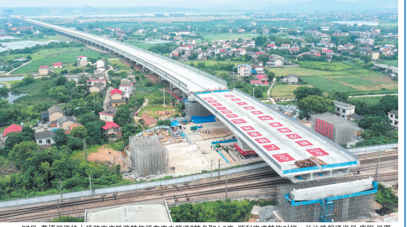
27日,暮坪湘江特大桥跨京广铁路转体桥在空中精准“转身”84.9度,顺利完成转体对接。长沙晚报通讯员 唐明 供图
