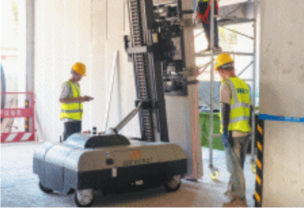
“90后”技术员张家康手持遥控器,像操作玩具汽车般精准操控着ALC墙板安装机器人。长沙晚报全媒体记者 邓迪摄
