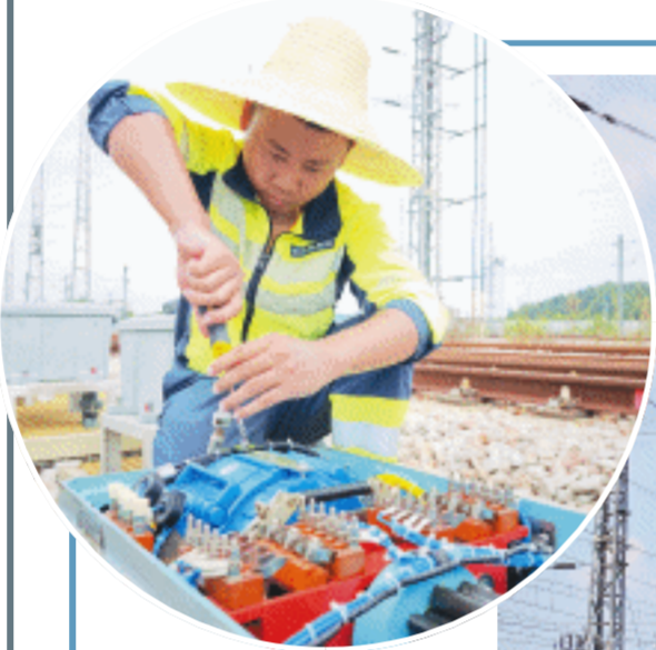
信号工在紧固转辙机螺栓。
