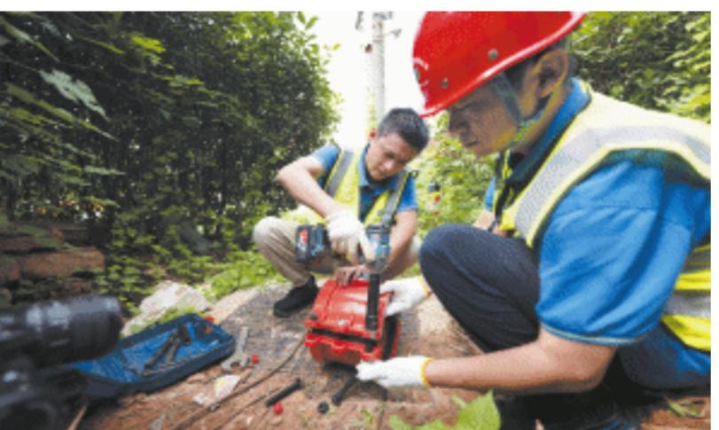
抢修员卸掉哈夫夹上的螺丝，准备对漏水点进行封堵。
