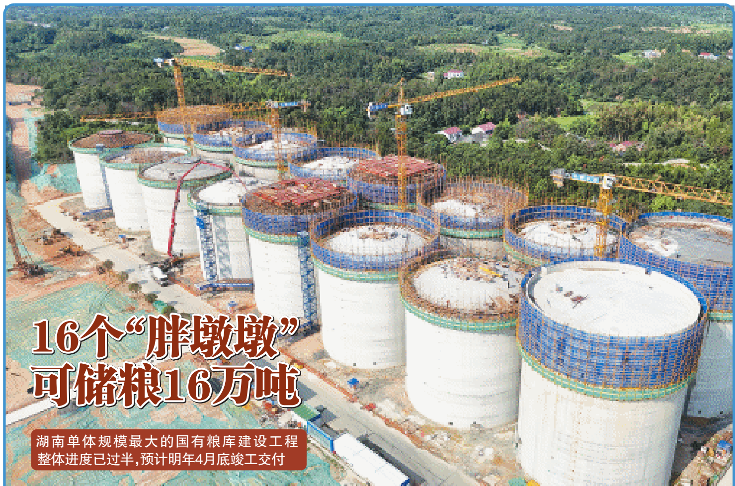
项目目前已完成16个浅圆仓主体建设，正在全力进行锥形顶和平顶施工。长沙晚报通讯员 杨亦可 摄
