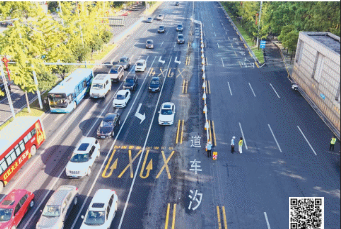
8月26日起，长沙首条“机器人式潮汐车道”投入试运行，芙蓉路福元路口北入口新设的可移动护栏机器人已完成全部安装与调试。
