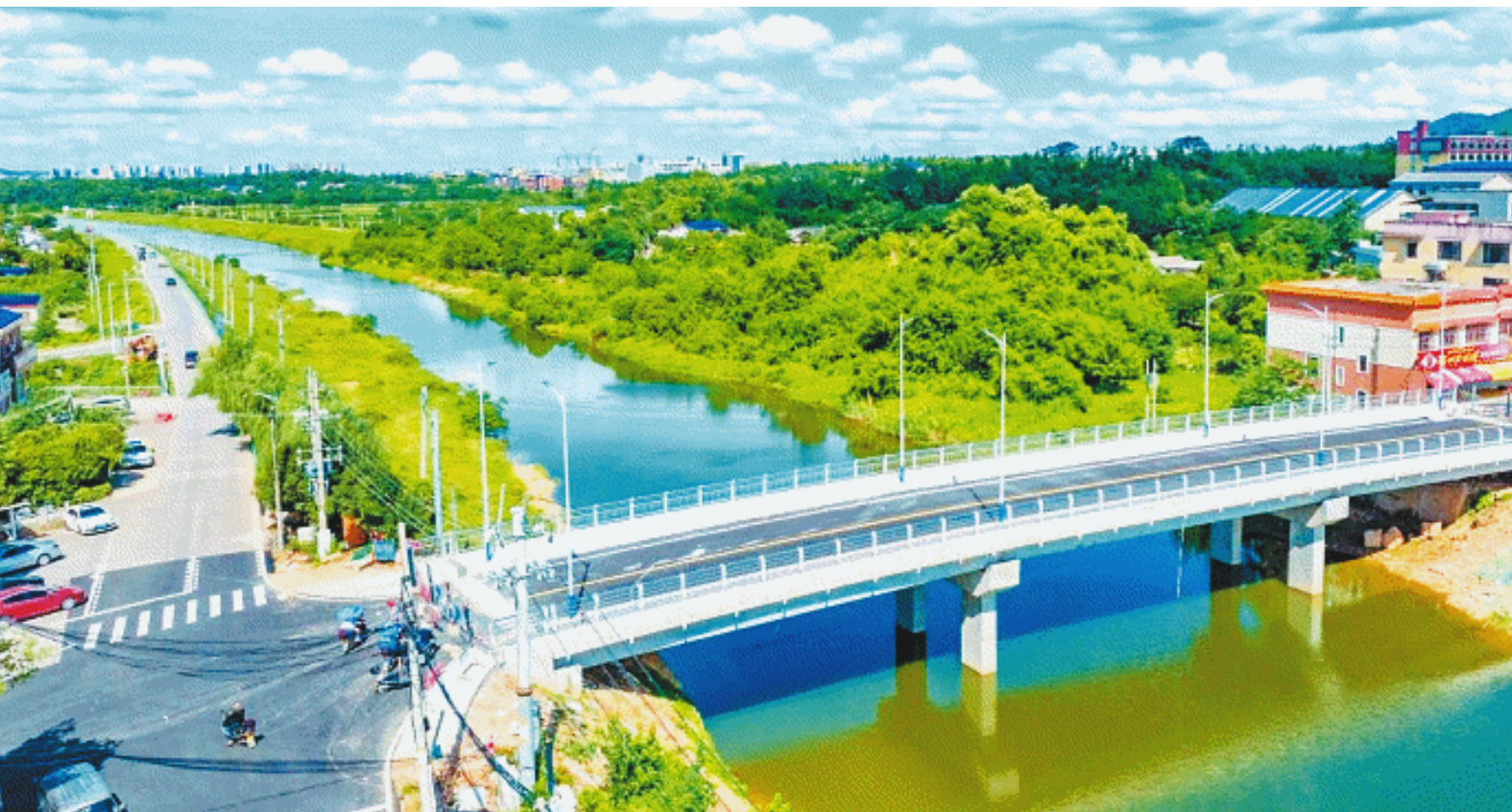
新的乌山大桥设计标准为二级公路,双向两车道,桥面宽12.9米,比之前宽了4米多。长沙晚报通讯员 龙宇 摄
