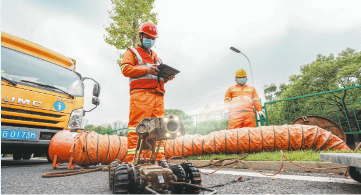
随着技术人员在平板电脑上轻点指令,一台搭载高清摄像头的“机器狗”正准备潜入地下管道进行检测。长沙晚报全媒体记者 陈飞 摄
