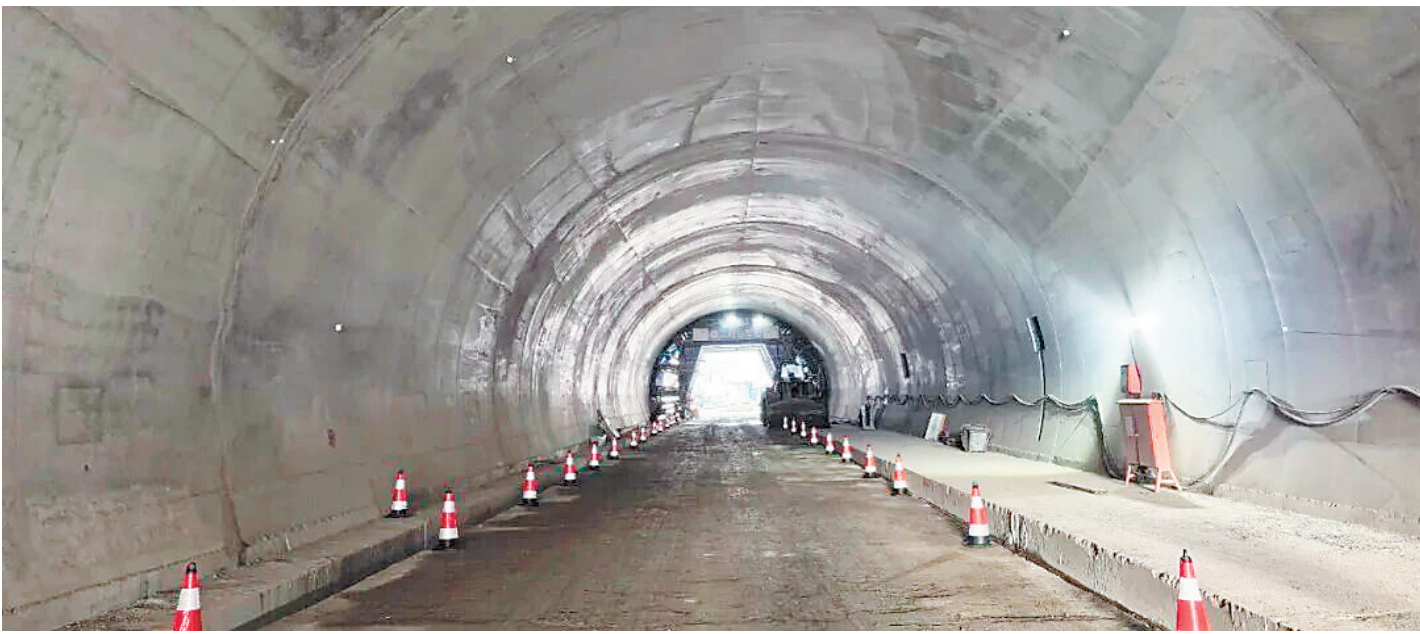
全长123米双洞连拱隧道洞身穿越断层破碎带，岩体松散，施工难度极大，是整个工程的“咽喉工程”。长沙晚报通讯员 叶芊芊 供图
