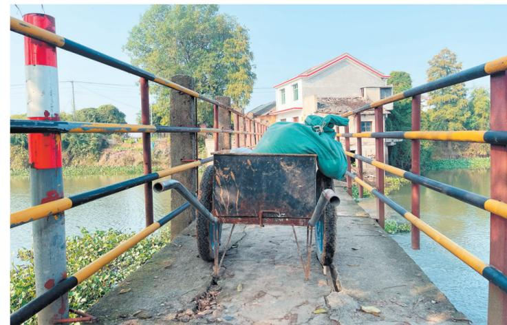
这座便桥仅约1.5米宽，桥面上已有数道明显裂缝，附近村民许多满载货物的两轮手推车轮不慎卡进了两块预制板之间的缝隙里。长沙晚报全媒体记者 舒元臻 摄
