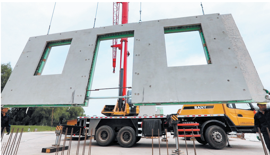
SPCS装配整体式叠合混凝土结构技术体系等一批本土创新技术成功落地并迭代升级。市住建局供图
