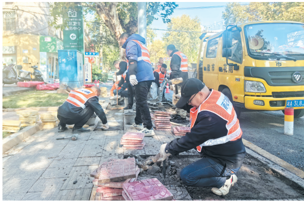
19 日上午 9 时，市政工人正对劳动中路的盲道进行精细改造。
