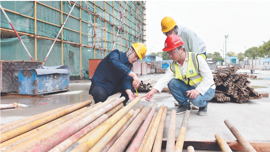
长沙县住房和城乡建设局质安站工作人员在建筑工地检查钢管管径。刘思源 摄
