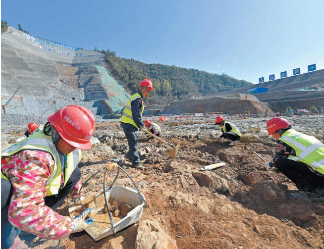
2023年1月31日,工人们采取镐子挖、铲子扒、高压水枪冲洗等办法,对一块块基岩进行仔细清理。
