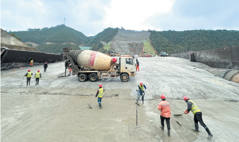
工人们在进行大坝坝顶施工。大坝为碾压混凝土重力坝,坝顶长420米,最大坝高69.5米,相当于20多层楼高。长沙晚报通讯员 刘静 供图
