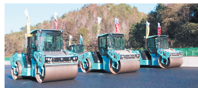
三一无人摊压机群在进行智能施工。受访者 供图
