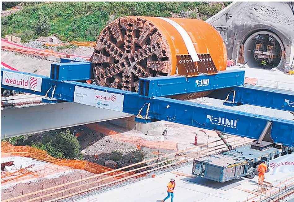
铁建重工盾构机整体托举过桥。长沙晚报通讯员 董构欧 供图
