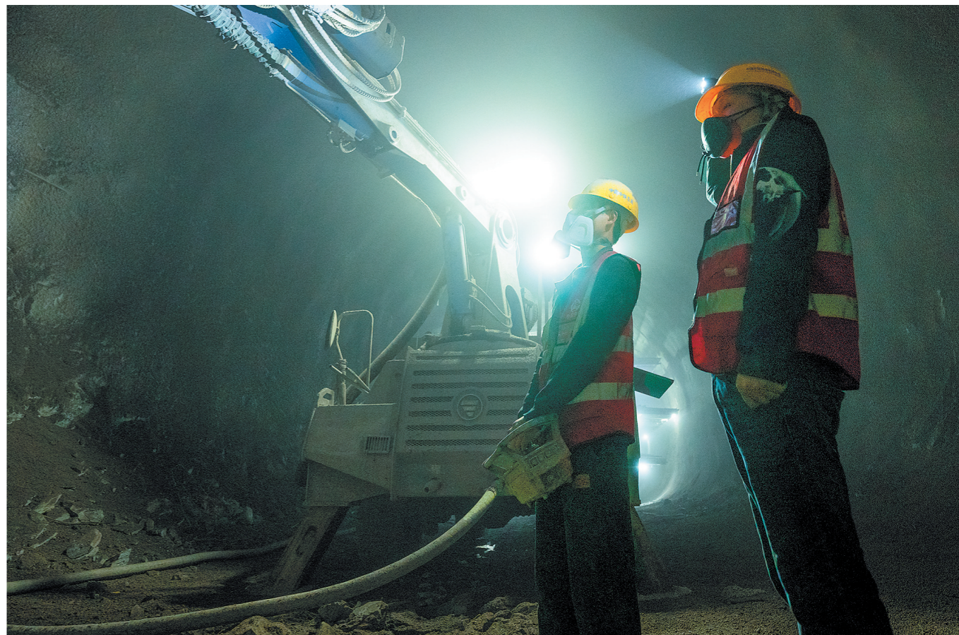
长浏快线蕉溪岭2号隧道内,生于1997年的喷浆工人曹昌在进行喷浆作业。
