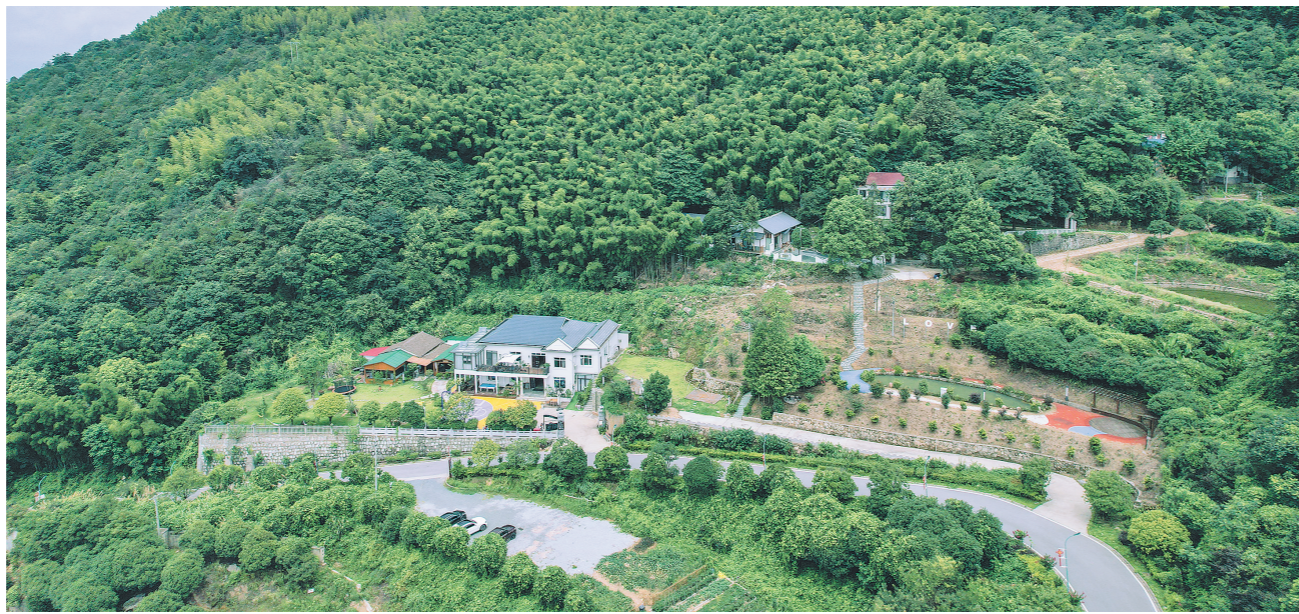
位于影珠山半山腰的桐乐·影山居民宿，是长沙县福临镇发展生态旅游、打造民宿集群、推进乡村振兴的重要支点。福临镇 供图
