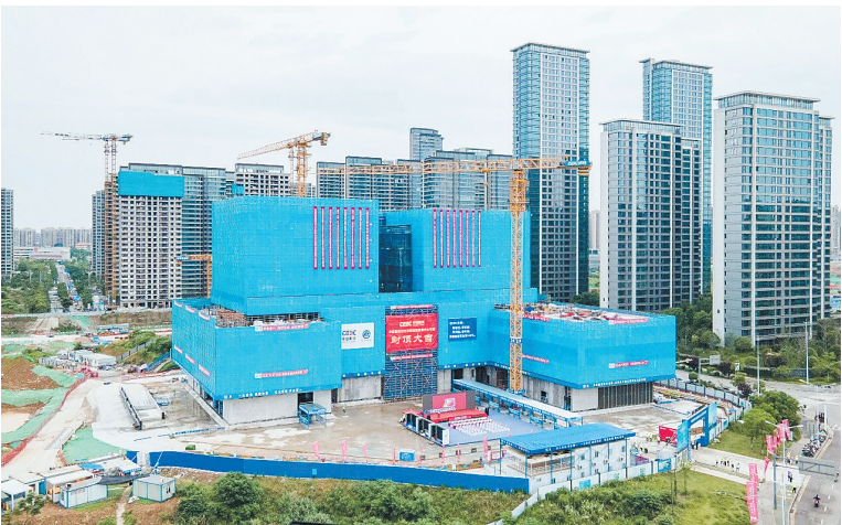
5月24日，位于梅溪湖国际新城二期的中国能建绿色民爆创新发展中心项目全面封顶。长沙晚报通讯员 胡翔 供图
