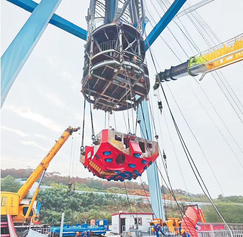
“钢铁脊梁号”现场吊装。长沙晚报通讯员 钟铁工 供图
