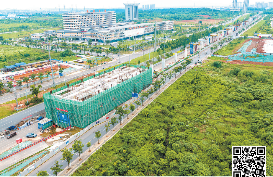
“长浏快线”项目部分车站雏形已现,隧道施工稳步开展,预制梁浇筑有序推进。长沙晚报全媒体记者 黄启晴 摄
