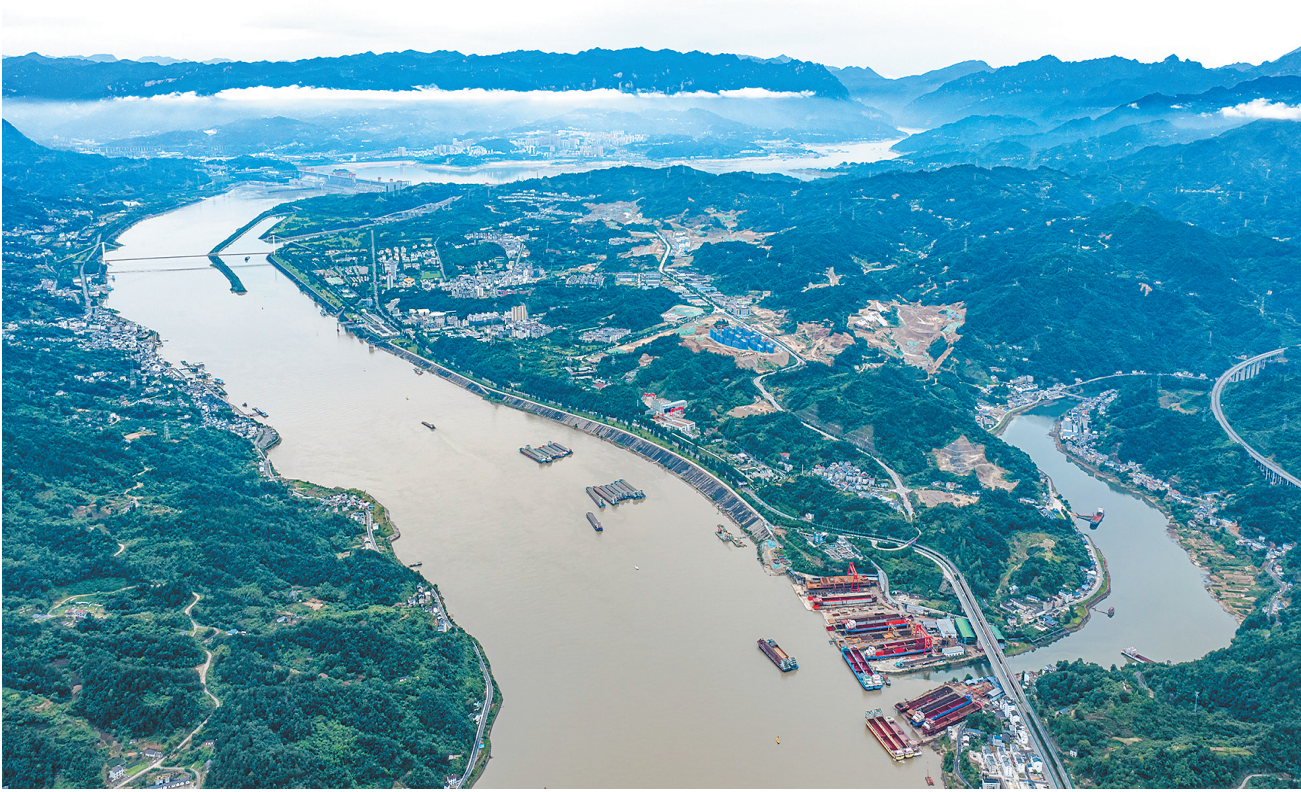
6月8日拍摄的三峡水运新通道工程三峡枢纽新通道施工现场。新华社记者 肖艺九 摄
