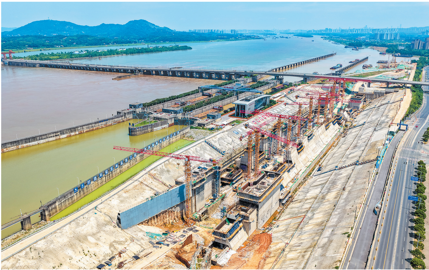
6月10日，中交四航局承建的湘江长沙综合枢纽三线船闸工程首段闸室主体结构顺利封顶，标志着项目主体结构土建施工取得关键性突破。长沙晚报全媒体记者 黄启晴 摄
