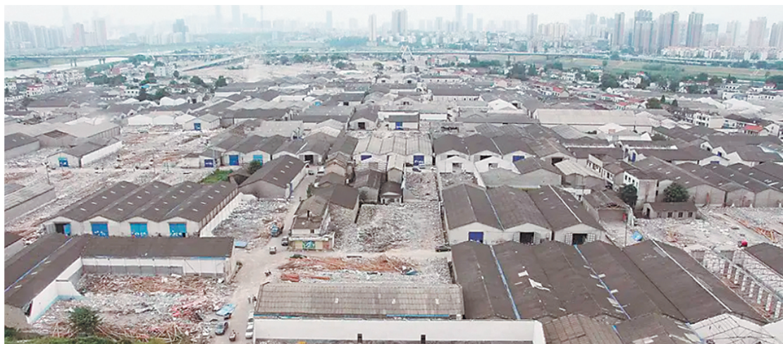
鸭子铺大片简易仓库拆除前的老照片。园区供图
