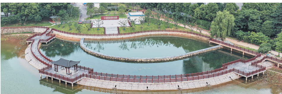
作为长沙目前最大的地下蓄水池，红旗渠水系排水改造项目于今年6月全面投入使用。余劭劼 摄
