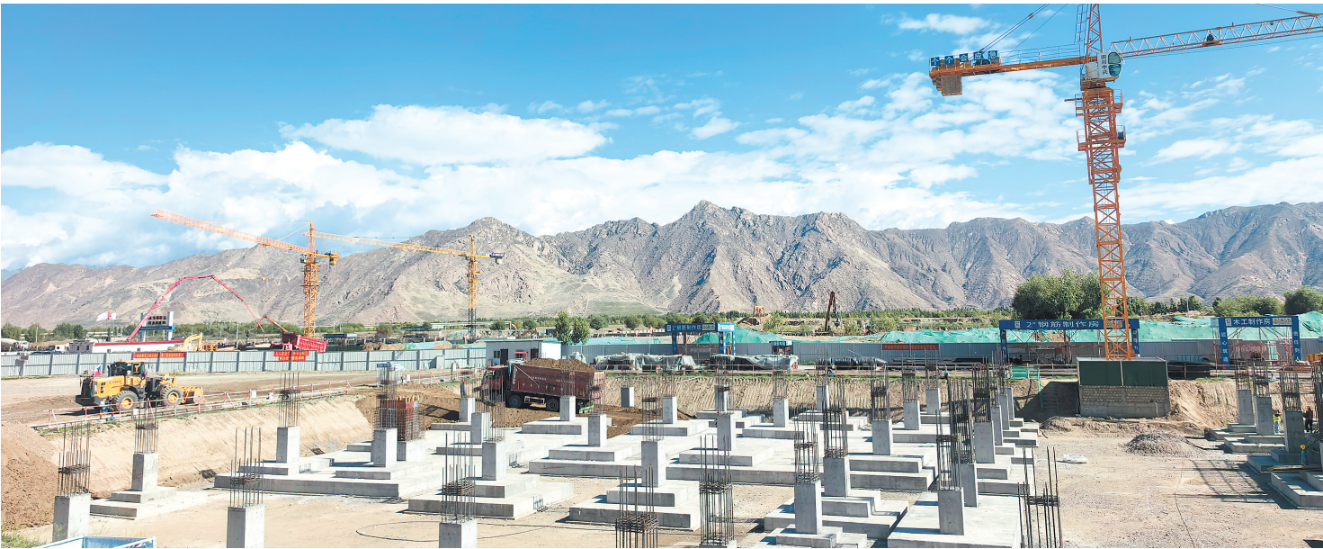
日前,西藏临空产业服务中心正在进行主体承台浇筑,项目建成后可集聚20家临空企业。长沙晚报通讯员 李劲夫 摄
