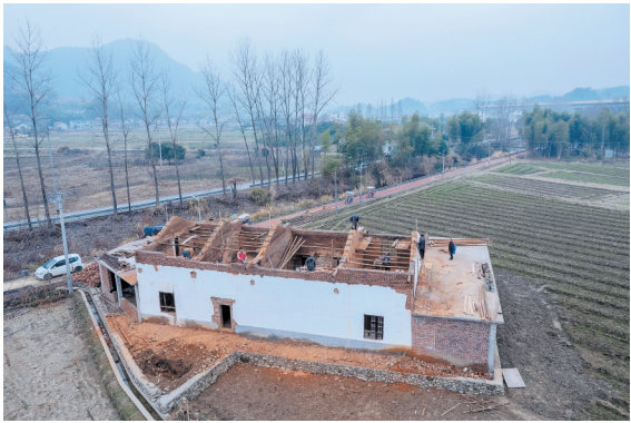
←2025年2月25日，改建中的老屋，以微改造、精修复的方式，保留夯土老宅的原始风貌与岁月痕迹，一点点清理荒芜、修缮、重塑。
