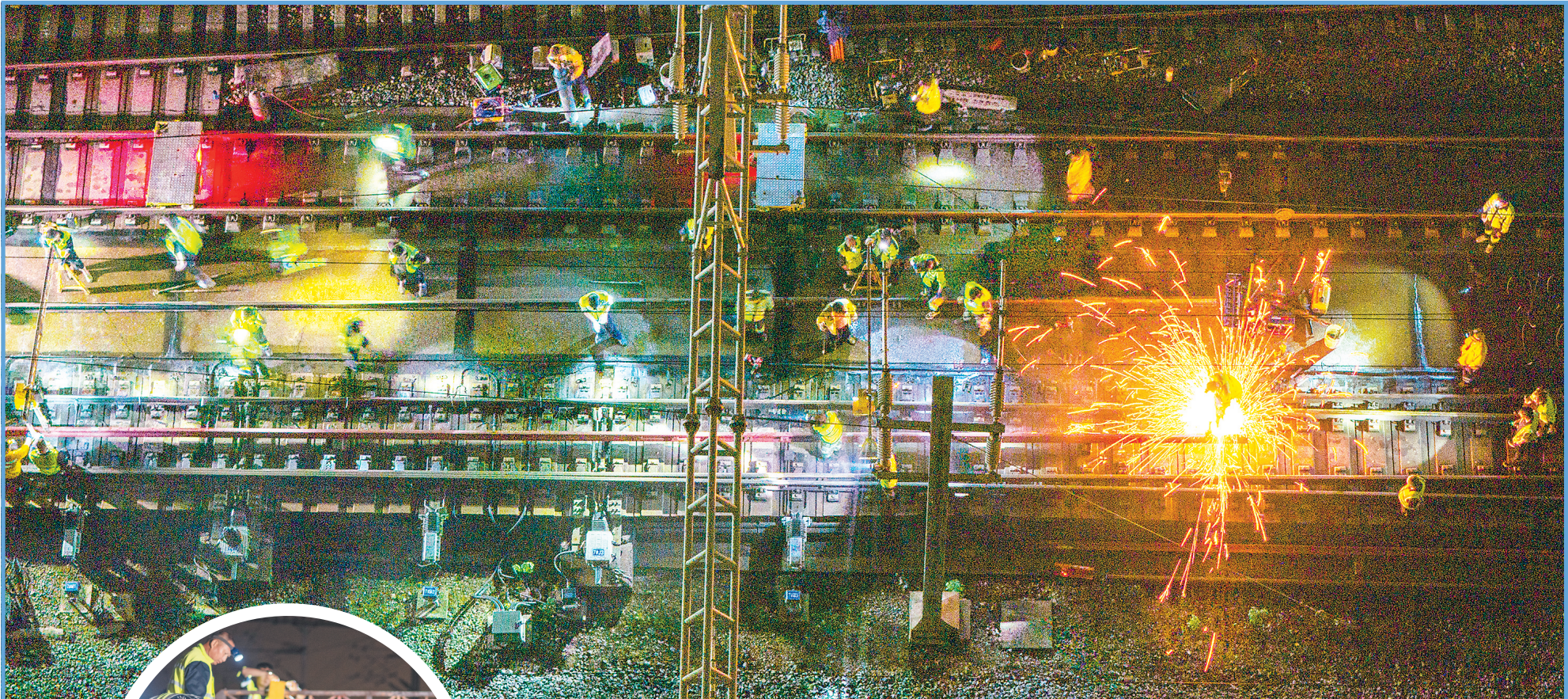
7月22日,凌晨1时29分,长沙高铁工务段组织施工人员对长沙南站武广场7号道岔进行换轨作业。现场机械轰鸣、工具碰撞、切割的火花交织。图片均为长沙晚报全媒体记者 黄启晴 摄
