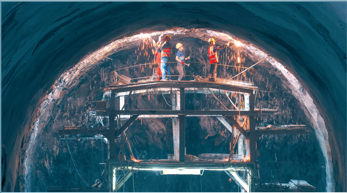
网片支护施工在隧道拱顶,热气直冒,犹如身处蒸屋之中。粉尘与水雾混合,在灯光下形成一道道“光帘”。
