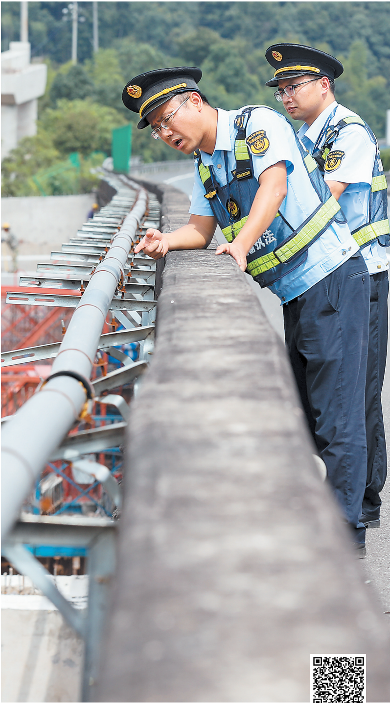
执法人员在浏江高速茶园湾枢纽施工点检查安全情况。长沙晚报全媒体记者 董阳 摄
