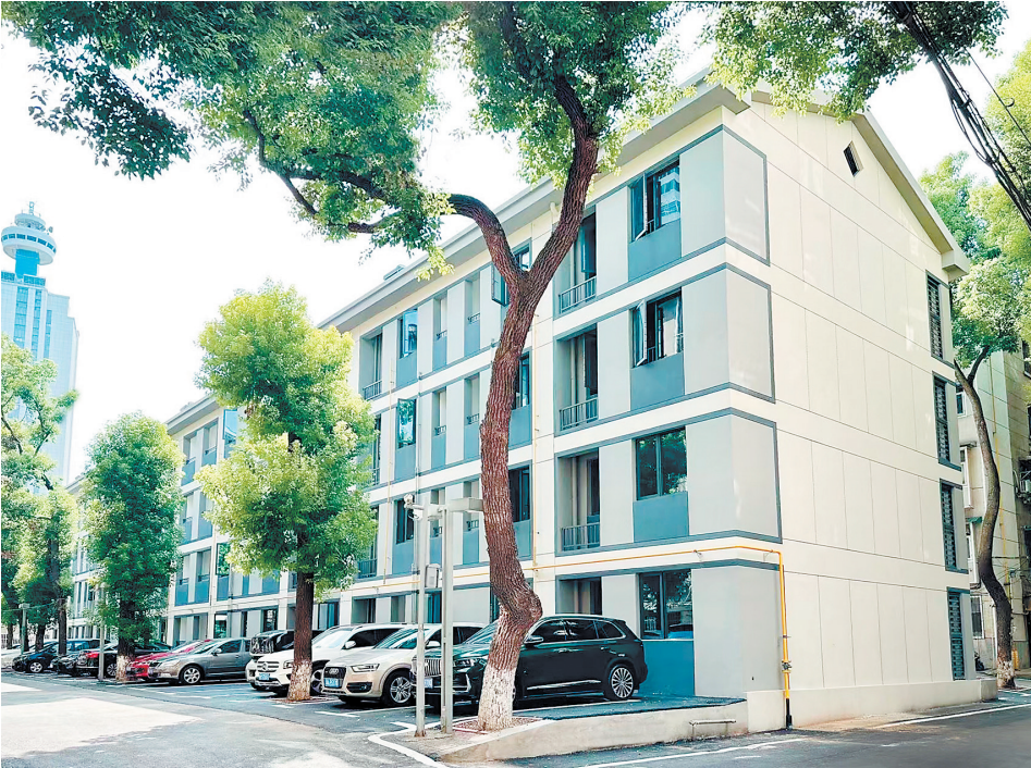
雨花区湘农桥社区二区9栋原拆原建圆了居民新居梦，成为长沙首个全过程代建的原拆原建项目。
