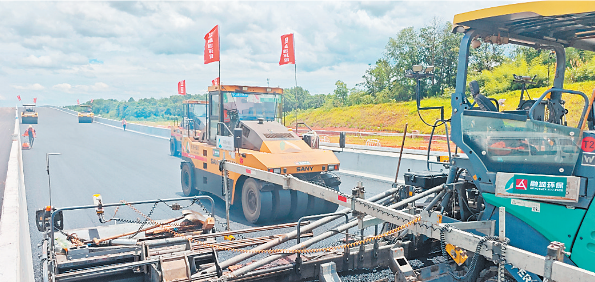
劳动东路(黄兴大道—龙峰大道)四标段首期沥青摊铺顺利完成,首次引入3D数字化智能摊铺系统。 长沙晚报通讯员 廖国栋 供图
