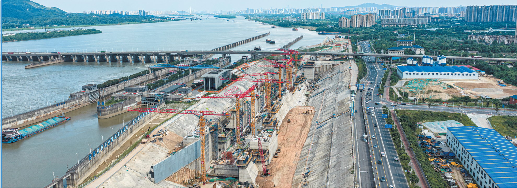
湘江长沙综合枢纽三线船闸项目正在加快建设。长沙晚报通讯员 毛兴蔚 供图
