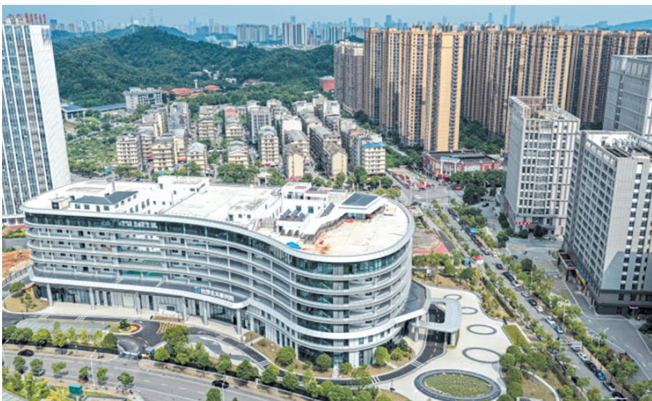
长沙北斗研究院总部基地,这座形如“大脚丫”的建筑,寓意“千里之行,始于足下”的务实精神。
