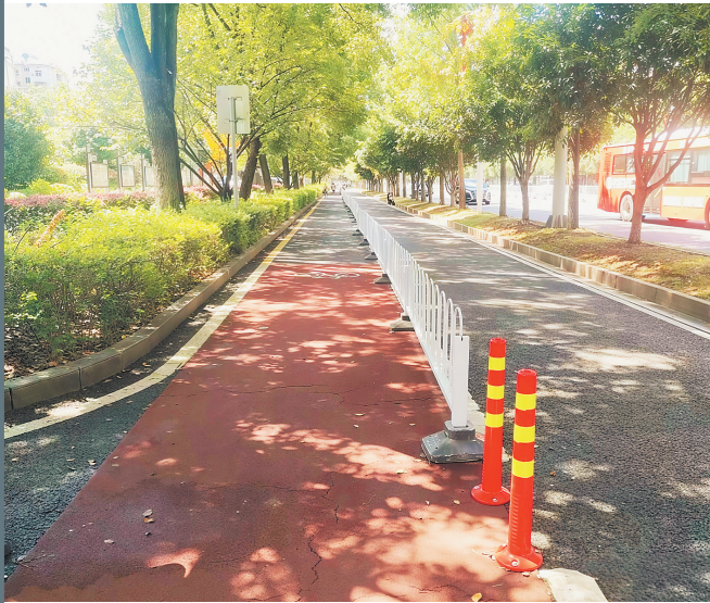
已安装好的隔离护栏。开福交管供图
