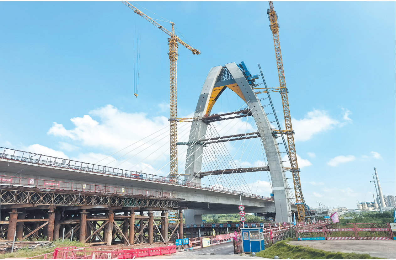
宁乡市发展路及发展大桥项目现场,桥塔矗立沔水河畔,“一叶方舟”造型雏形初现。 长沙晚报全媒体记者 张禹 摄
