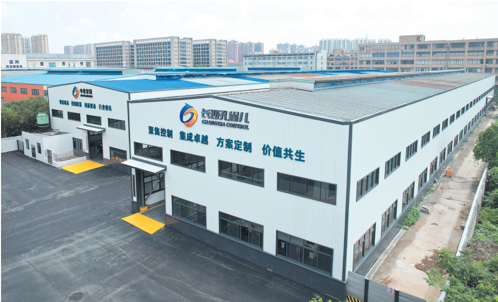
原金翔铜业老厂房改造后,吸引了长沙孔雀儿签约入驻。长沙晚报全媒体记者 易亿 摄
