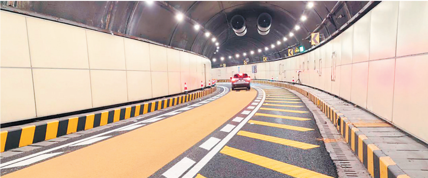
提质改造后的营盘路隧道匝道。市城管局供图
