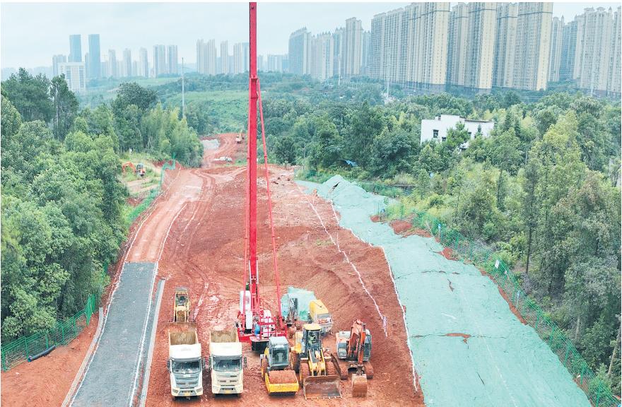
首个路基工点顺利开工,标志着长赣高铁湖南段路基工程进入全面施工阶段。 长沙晚报通讯员 杨程文 摄
