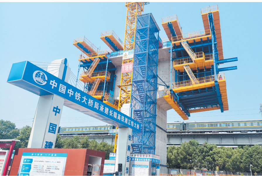
该智能造桥机集多种功能于一体,能实时监控自动走行、姿态调整、受力状态及施工环境。长沙晚报通讯员 杨洁芳 摄
