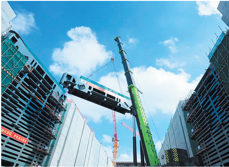
中联重科起重机助力平陆运河项目吊装作业。 长沙晚报通讯员 杨牧意 供图
