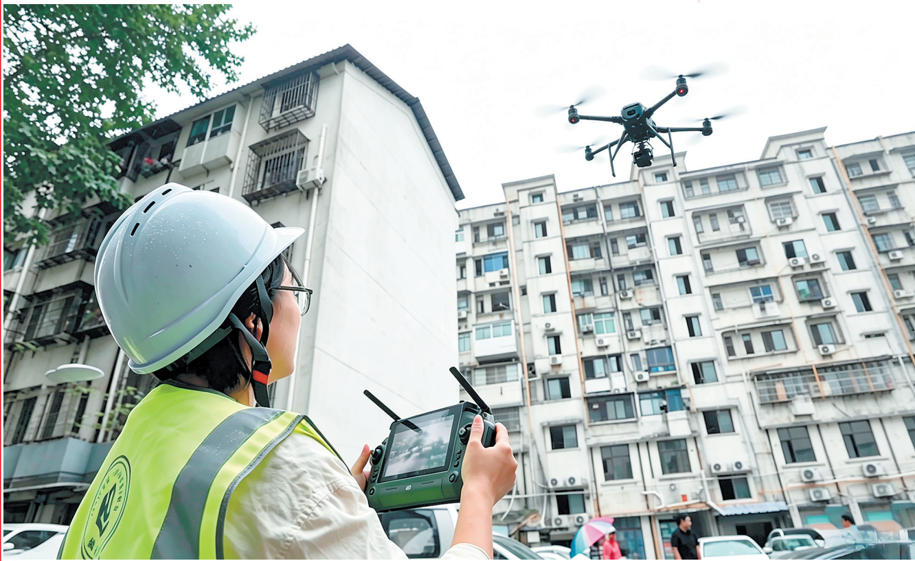
技术人员正在运用无人机为老旧房屋进行安全“体检”。邹麟 摄
