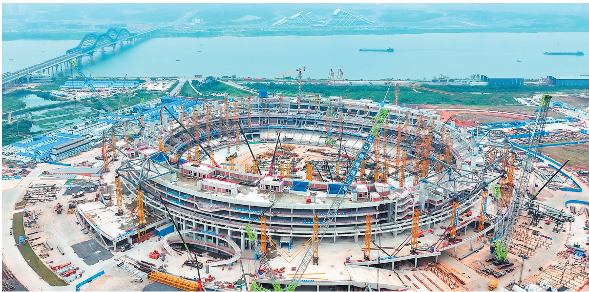
长沙奥体中心“一场两馆”混凝土主体全面封顶。 长沙晚报全媒体记者 尹昊天 摄
