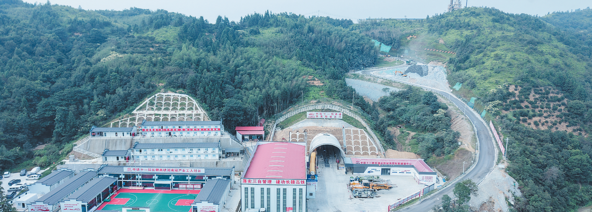
国庆假期，长赣高铁湖南段建设现场热火朝天，5000余名建设者坚守施工一线，全力保障项目建设有序推进，这是建设中的苏家隧道。长沙晚报通讯员 游智宇供图
