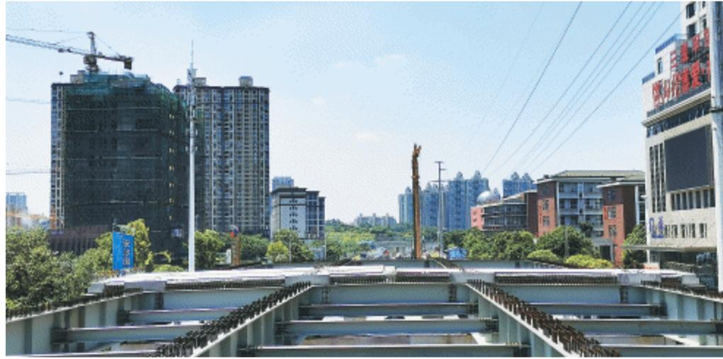
万家丽路快改北延线主线桥采用国内最先进的钢板组合梁新型结构，将实现桥梁结构全生命周期最优化。
