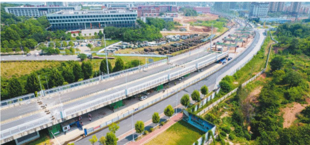
8月3日，由中铁五局承建的万家丽路快速化改造北延线工程既有万家丽路高架桥开始顶升施工，为项目全线早日通车奠定基础。长沙晚报全媒体记者 郭雨滴 通讯员 罗健 单升前 摄影报道
