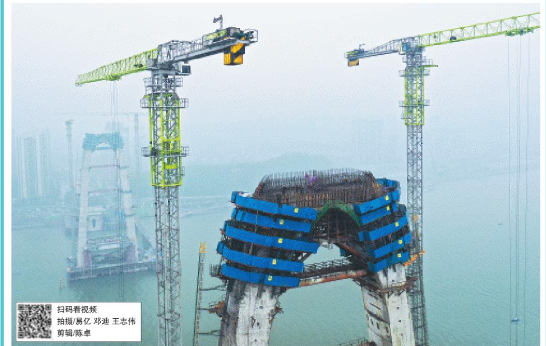
3月6日,长沙兴联路大通道项目跨湘江主桥50号主墩上横梁完成浇筑,标志着项目主桥首个主塔顺利合龙。长沙晚报全媒体记者 王志伟 摄
